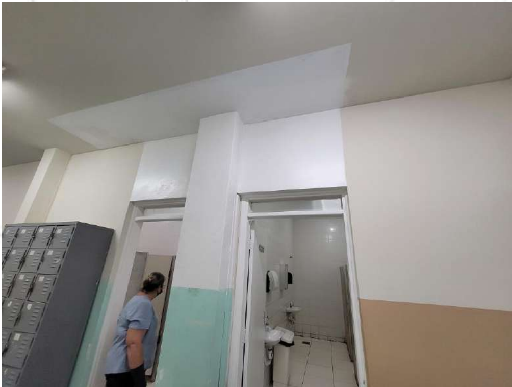
FOTO 2. Vista para o ponto descascado, aplicado massa corrida e nova pintura.
