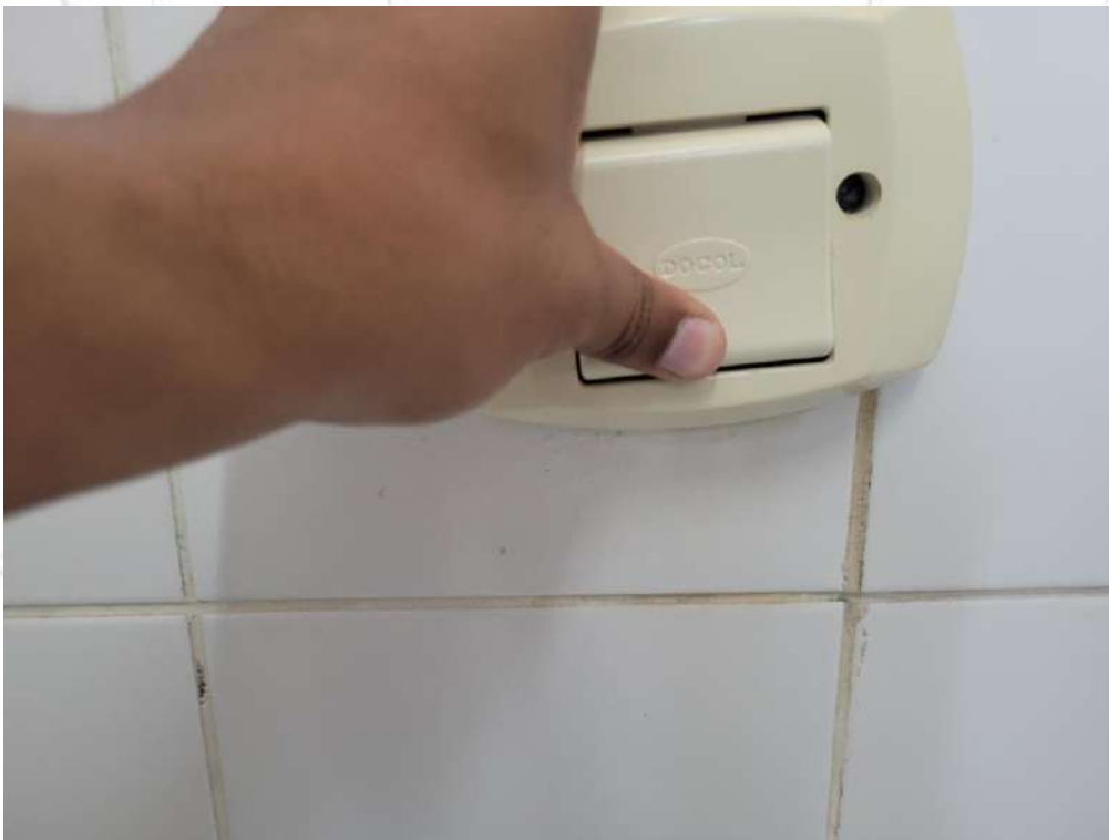
FOTO 30. Vista para o reparo da válvula trocada, sem vazamento na parede.
