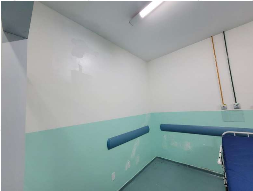
FOTO 14. Vista para o destacamento da parede e aplicação de massa corrida e lixamento.
