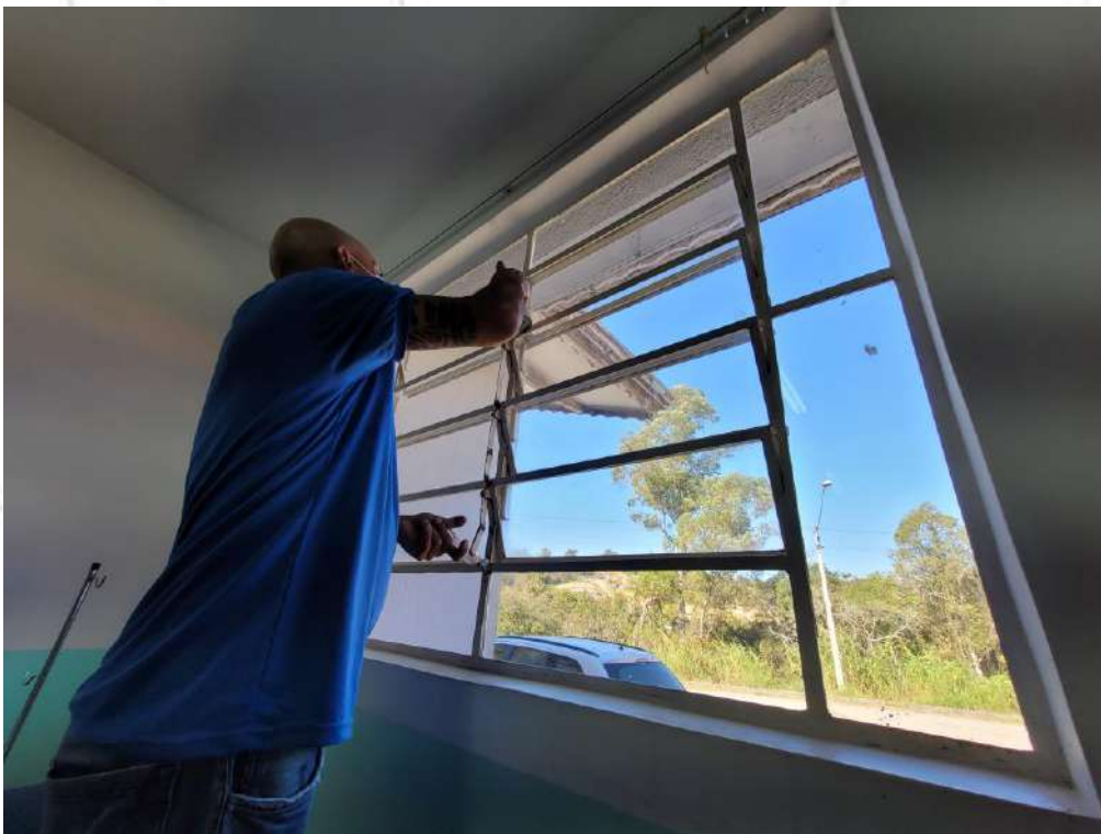
FOTO 54. Todas as janelas foram lubrificadas.
