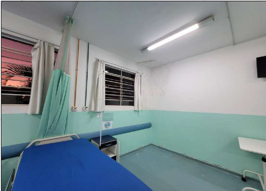
FOTO 10. Vista para a limpeza, aplicação de massa corrida, e lixamento.
