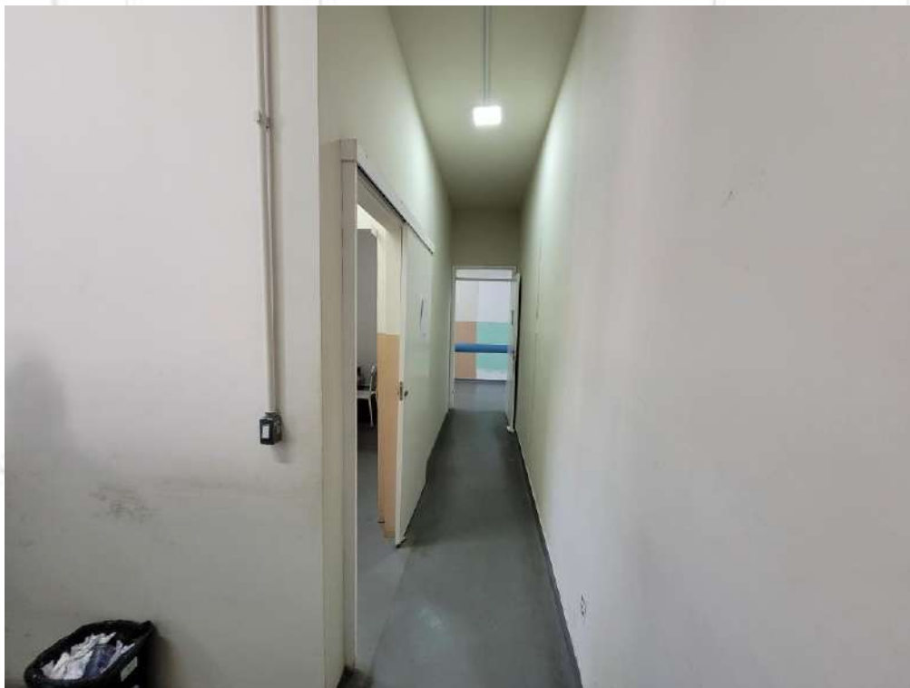
FOTO 12. Vista para a instalação de nova luminária.
