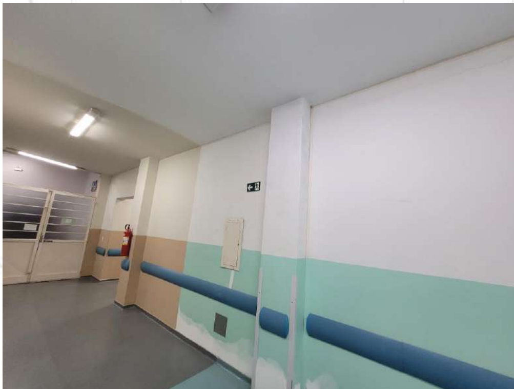
FOTO 6. Vista para o ponto descascado, aplicado massa corrida e nova pintura.
