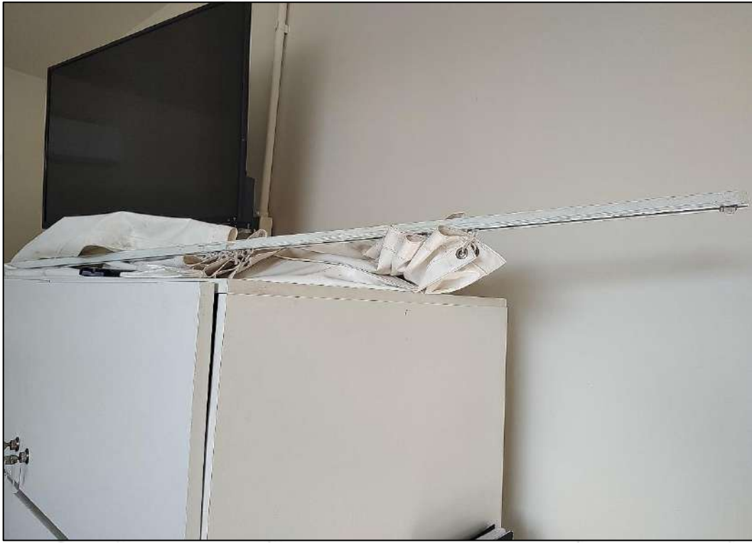
FOTO 47. Cortina do conforto médico danificada.
